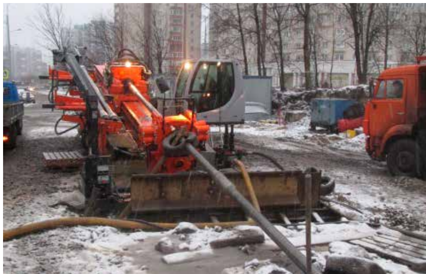
Энергетики выполняют прокол методом горизонтально направленного бурения для прокладки кабеля под Финским заливом со стороны Морской набережной
