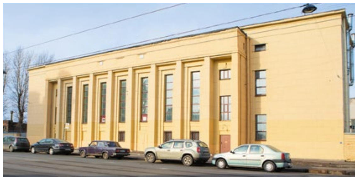
Подстанция 35/6 кВ № 13 «Волхов-Василеостровская»
