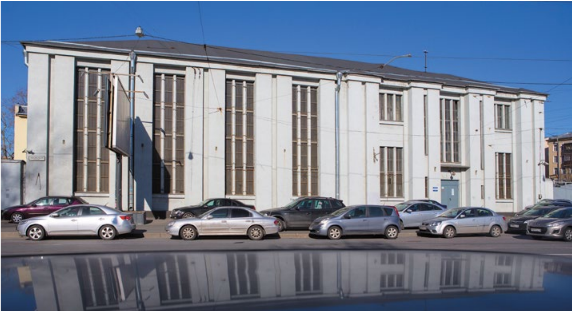
Подстанция 35/6 кВ № 11 «Выборгская»
