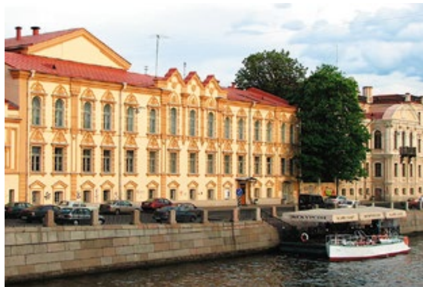
Две новых подземных трансформаторных подстанции, в том числе, обеспечат дополнительную мощность библиотеке им. Маяковского
