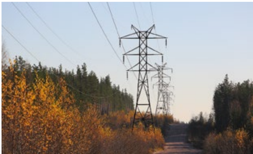
С начала года в зоне ответственности «ВЭС» построено и реконструировано 550 км воздушных линий
