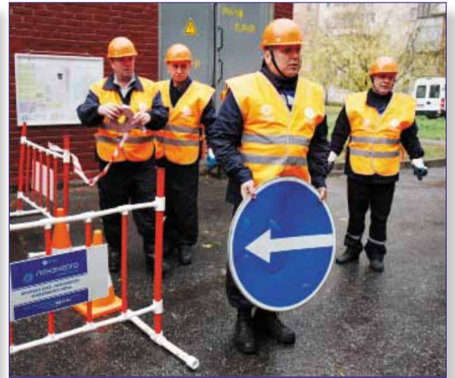
#lenenergo Бригада ОАО «Ленэнерго» заменила трансформатор на подстанции. В масштабной общегородской тренировке по организации аварийно-восстановительных работ в зимний период участвовали городские службы, в том числе пожарные расчеты МЧС. ОАО «Ленэнерго» успешно отработало действия по замене трансформатора на подстанции после пожара
